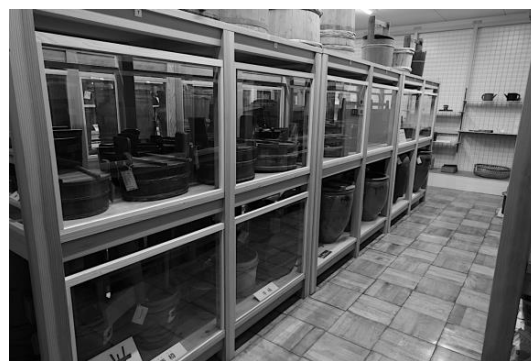
写真10 砺波民具展示室の収蔵棚に設置されたアクリルのガード
