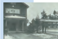
旧校舎第一号館および第三号館
