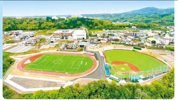
2023年春に完成した金沢学院グリーンフィールドⅢ(陸上競技場・野球場)
