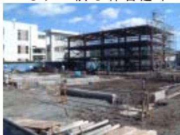
建設が進む「清鐘寮」
