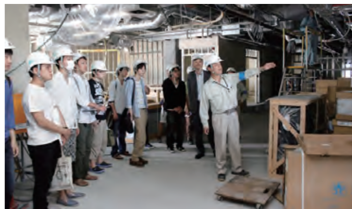
金沢中心市街地の再開発ビル工事現場を見学する経営情報学部の学生
